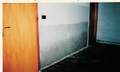
Verificare l'assenza di parti incoerenti. Procedere con abbondante idratazione delle superfici.
