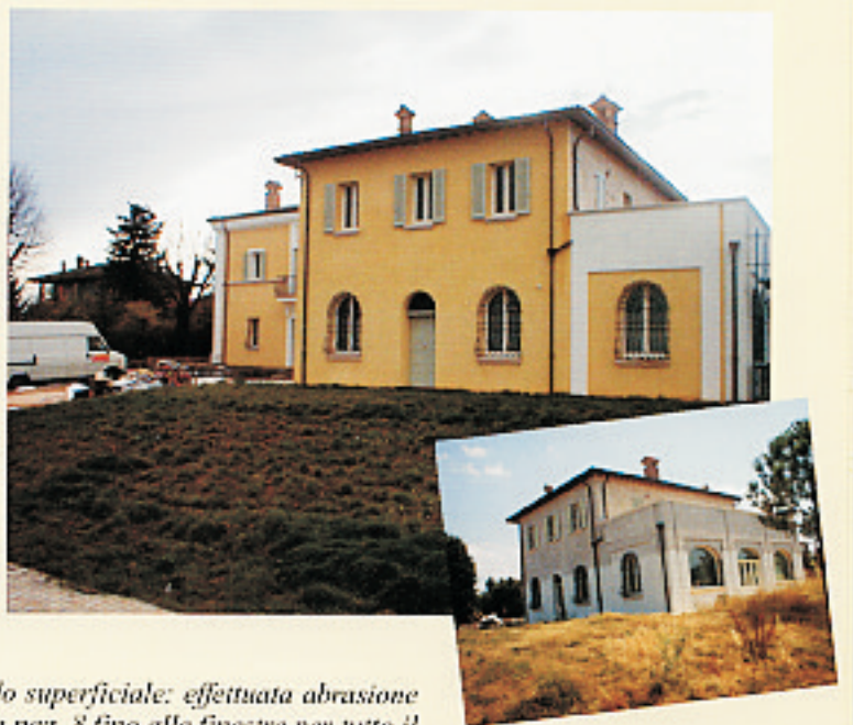
Murature con massicce tracce d'umidità persistenti; trattamento con Coprox Intonaco nel ciclo descritto a pag. 8 fino a 250cm per tutto il perimetro. Ad asciugatura avvenuta finitura con intonchino ai silicati.
