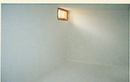
Applicazione 2 mani di Pittura Cementizia Coprox colorata, gialla.
