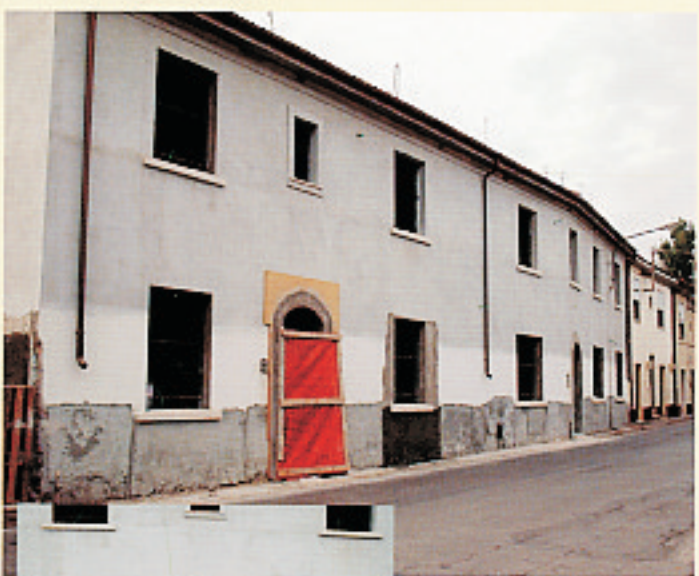
Complesso residenziale in esterno, soggetto ad umidità di risalita: effettuata abrasione superficiale del vecchio supporto, con applicazione ciclo di risanamento Intonaco Coprox tipo S lungo la zoccolatura e finito con Intonaco Coprox tipo M colorato, applicato con effetto rustico.
