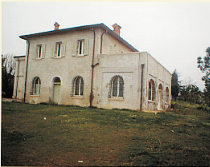
Muri perimetrali esterni soggetti ad umidità di risalita con degrado superficiale: effettuata abrasione superficiale e trattamento con Coprox Intonaco nel ciclo descritto a pag. 8 fino alle finestre per tutto il perimetro. Ad asciugatura avvenuta tinteggiatura con silossanici.
