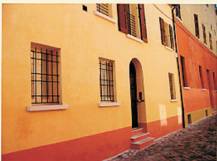
Risanamento per deumidificazione in palazzo nel centro storico di Ravenna. Effettuata abrasione superficiale e ripristinati i livelli del fondo con malte cementizie da rinzaffo, si è intervenuti con Intonaco Coprox tipo S con interposta rete in fibra vetro tra le prime due mani, finitura con tipo Z.
