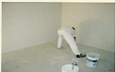
Applicazione 2 mani Intonaco Coprox con interposizione rete in fibra di vetro. (Anche a pavimento)
