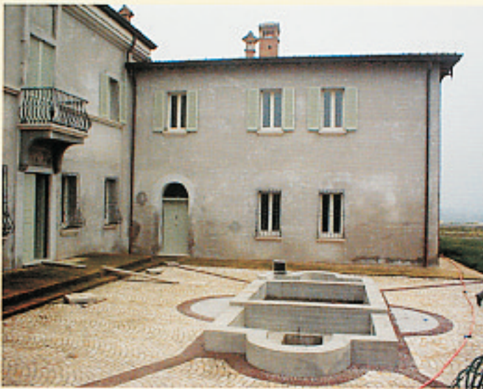
Murature con massicce tracce d'umidità persistenti; trattamento con Coprox Intonaco nel ciclo descritto a pag. 8 fino a 250cm per tutto il perimetro. Ad asciugatura avvenuta finitura con intonchino ai silicati.
