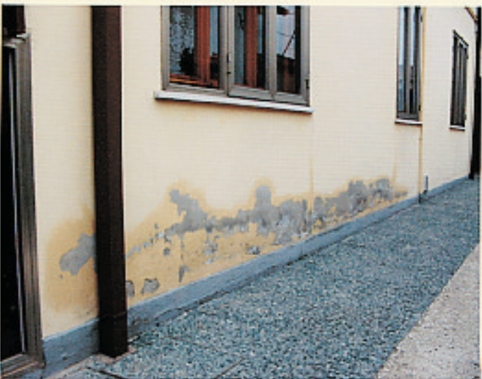
Muri perimetrali esterni soggetti ad umidità di risalita con degrado superficiale: effettuata abrasione superficiale e trattamento con Coprox Intonaco nel ciclo descritto a pag. 8 fino alle finestre per tutto il perimetro. Ad asciugatura avvenuta tinteggiatura con silossanici.
