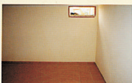
Applicazione 2 mani di Pittura Cementizia Coprox colorata, gialla.
