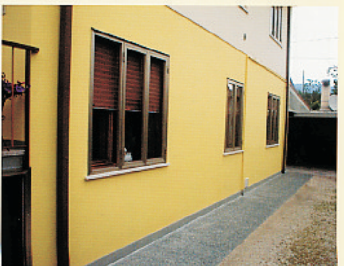
Muri perimetrali esterni soggetti ad umidità di risalita con degrado superficiale: effettuata abrasione superficiale e trattamento con Coprox Intonaco nel ciclo descritto a pag. 8 fino alle finestre per tutto il perimetro. Ad asciugatura avvenuta tinteggiatura con silossanici.
