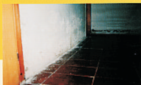
Abrasiono superficiale al 50% più in alto della linea d'evaporazione. Asportare aree non coese.
