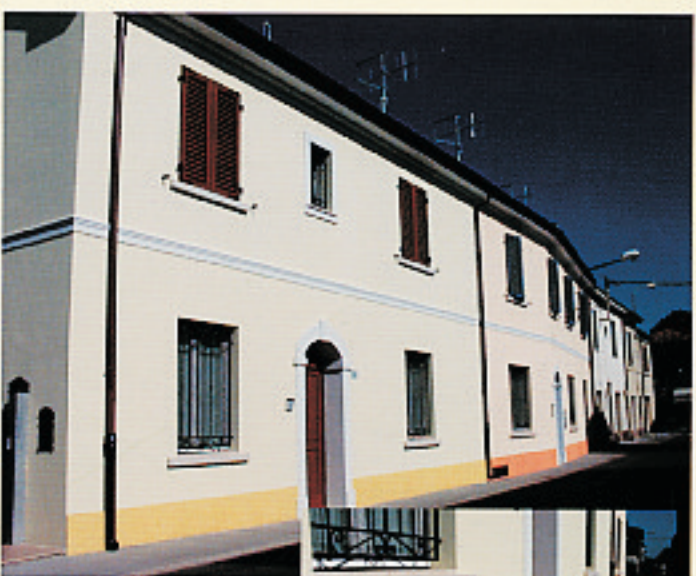
Complesso residenziale in esterno, soggetto ad umidità di risalita: effettuata abrasione superficiale del vecchio supporto, con applicazione ciclo di risanamento Intonaco Coprox tipo S lungo la zoccolatura e finito con Intonaco Coprox tipo M colorato, applicato con effetto rustico.
