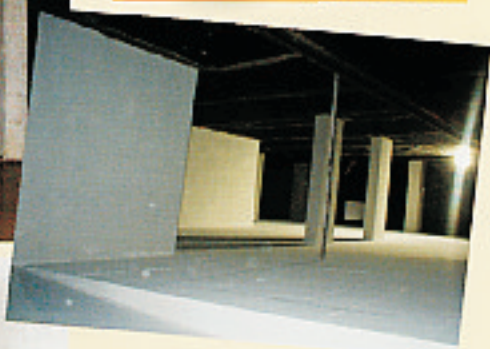
Sotterraneo con intense infiltrazioni d'acqua salata per controspinta dal terreno retrostante. Intervento in controspinta (sopra descritto) con creazione di sguscio di rinforzo tra parete e pavimento.
