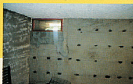
Abrasione superficiale e martellinatura dei supporti, successiva passivazione dei ferri d'armatura.
