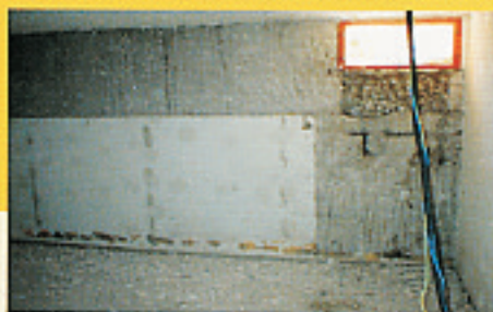
Abrasione superficiale e martellinatura dei supporti, successiva passivazione dei ferri d'armatura.
