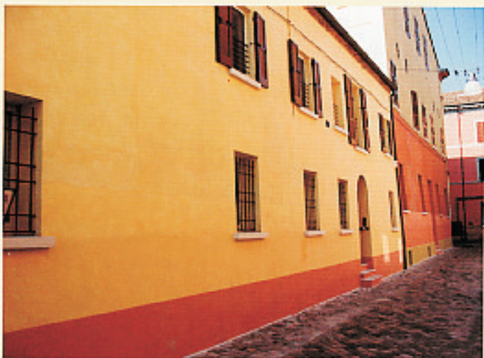
Risanamento per deumidificazione in palazzo nel centro storico di Ravenna. Effettuata abrasione superficiale e ripristinati i livelli del fondo con malte cementizie da rinzaffo, si è intervenuti con Intonaco Coprox tipo S con interposta rete in fibra vetro tra le prime due mani, finitura con tipo Z.
