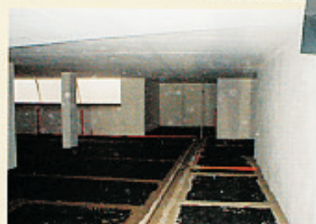
Sotterraneo con intense infiltrazioni d'acqua salata per controspinta dal terreno retrostante. Intervento in controspinta (sopra descritto) con creazione di sguscio di rinforzo tra parete e pavimento.
