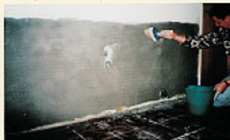
Verificare l'assenza di parti incoerenti. Procedere con abbondante idratazione delle superfici.
