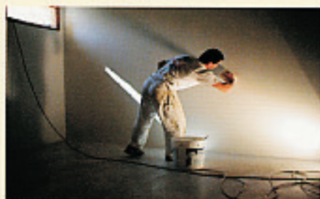
Applicazione 2 mani Intonaco Coprox con interposizione rete in fibra di vetro. (Anche a pavimento)
